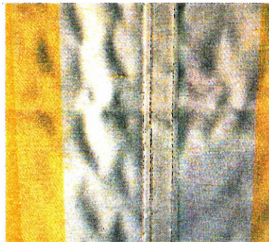
Welligkeiten im Nahtbereich
